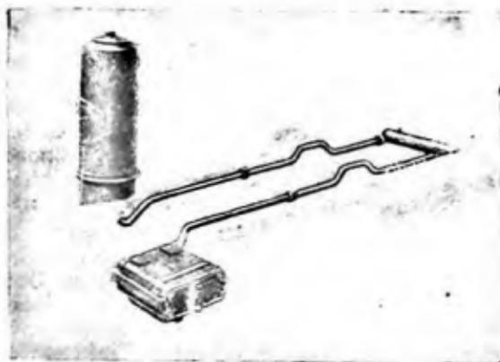
FIG. 10. — Ensemble gazogène-refroidisseur-épurateur monté sur camion.
